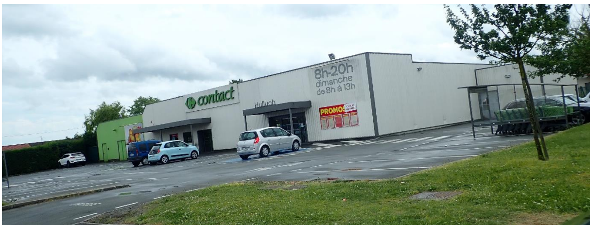
Le bâti économique de la rue du Général Leclerc mériterait une meilleure intégration végétale et un choix de teintes moins voyant
