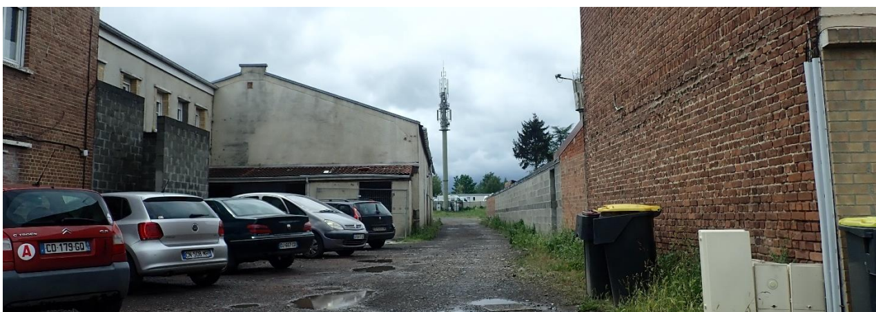
d- Pylône peu visible mais dévalorisant lorsqu'il se donne à voir
