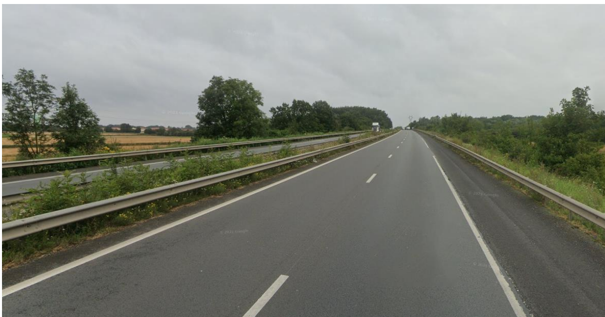
La RN17 implantée sur talus au sein d'Hulluch est en 2x2 voies
