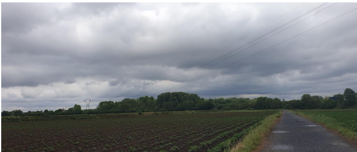
Les lignes électriques Haute Tension sillonnant le nord du territoire
