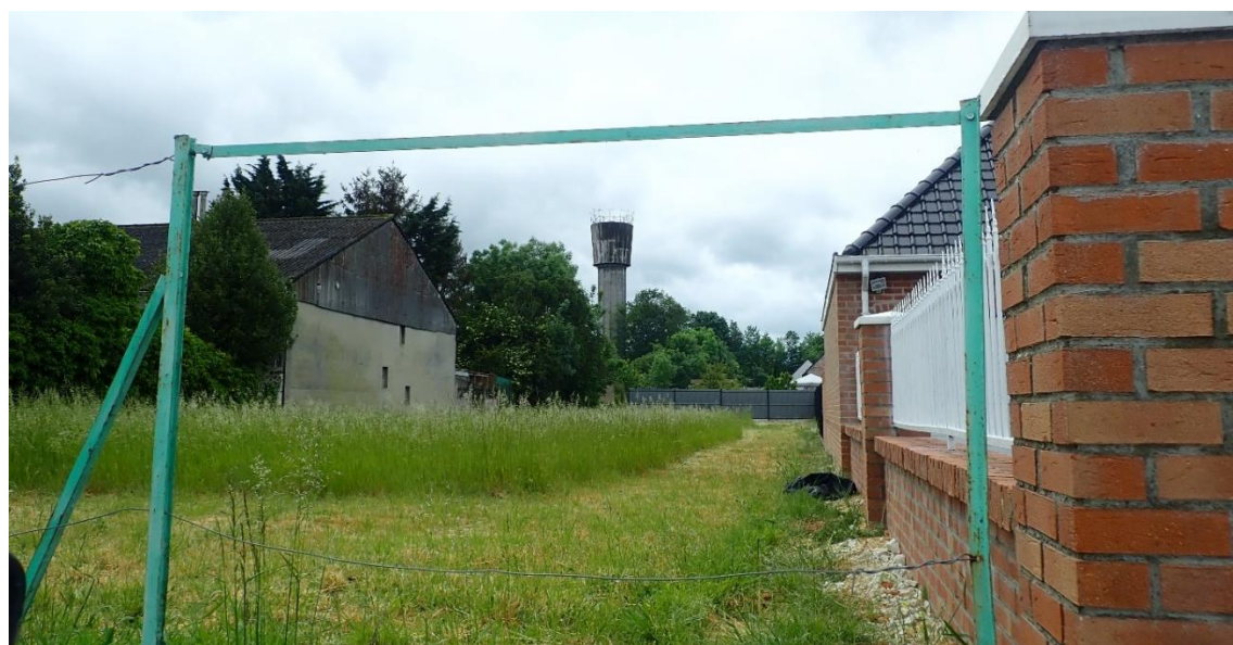
Le château implanté au nord en profondeur du tissu bâti
