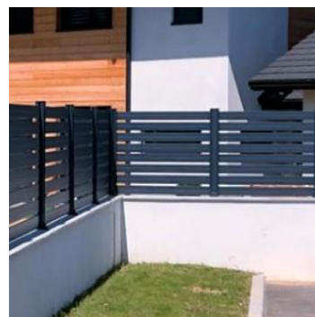
Mur surmonté d'un dispositif à claire-voie
